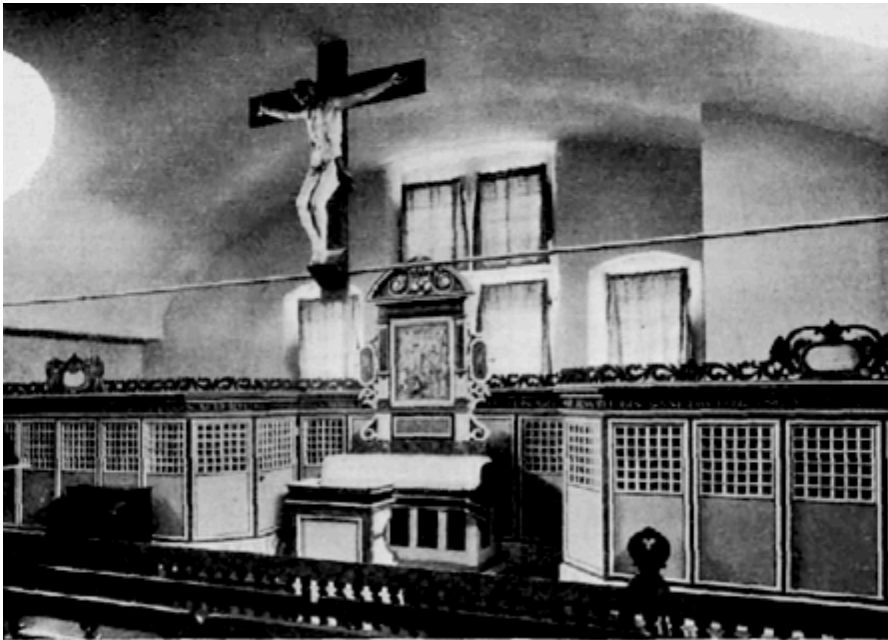
Das Amtsgericht Lichterfelde. — Abb. 35 Betsaal.
